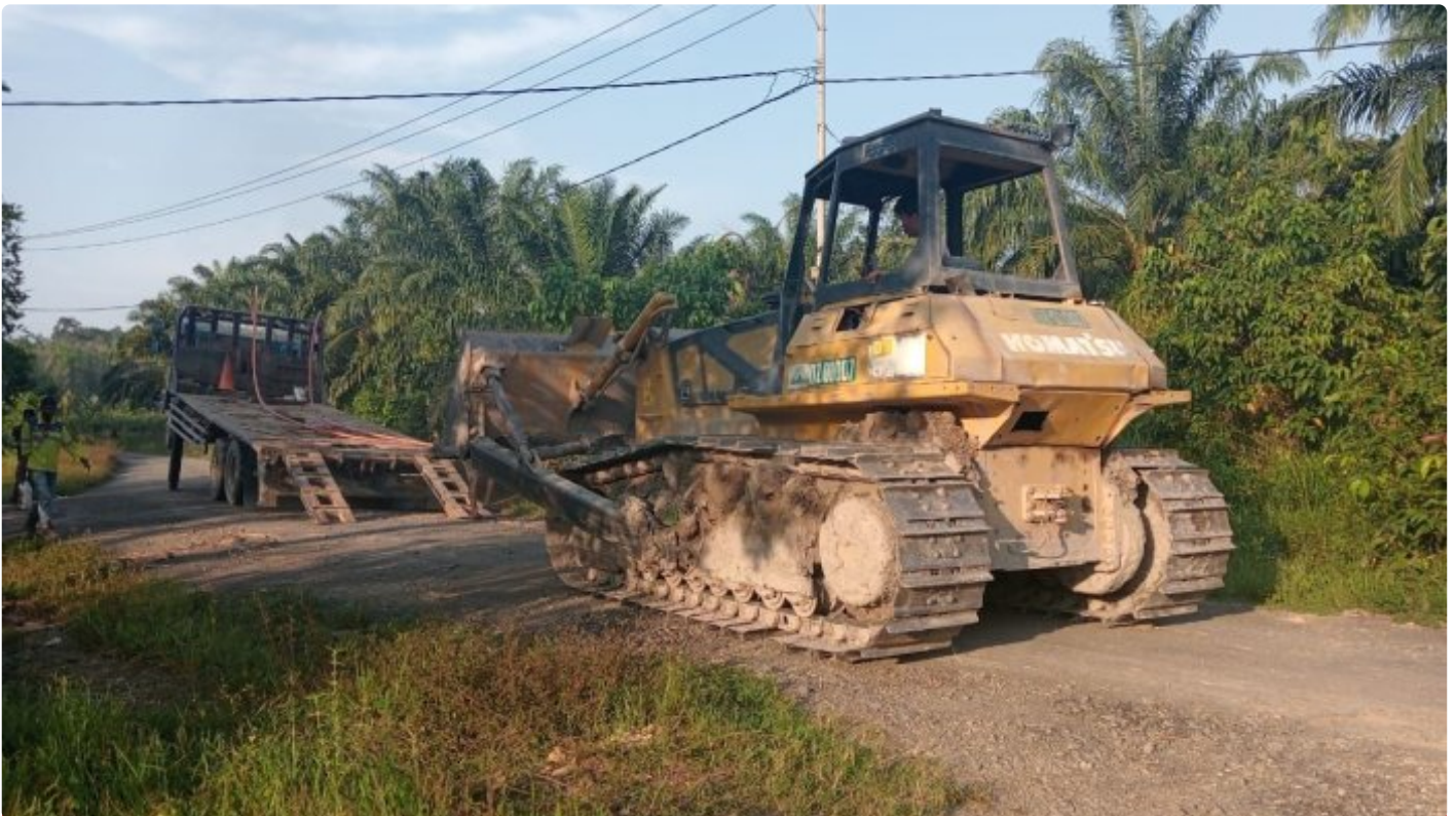
Percepat Pembukaan Badan Jalan Satgas TMMD Ke- 118 Turunkan Bulldozer
