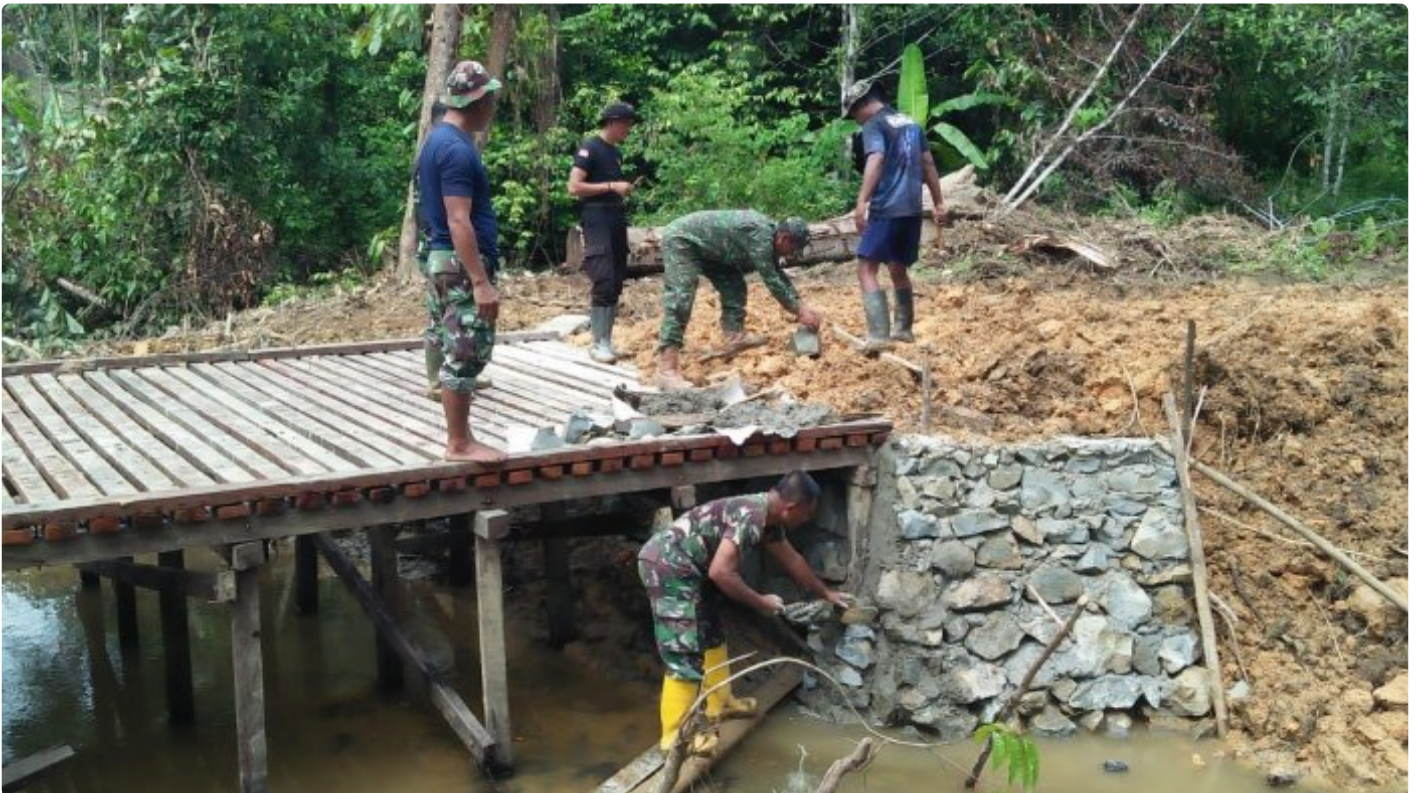
Progres Sasaran Jembatan Kayu Ulin TMMMD Ke- 118 Wiltas Kodim/Malinau Capai 75 Persen
