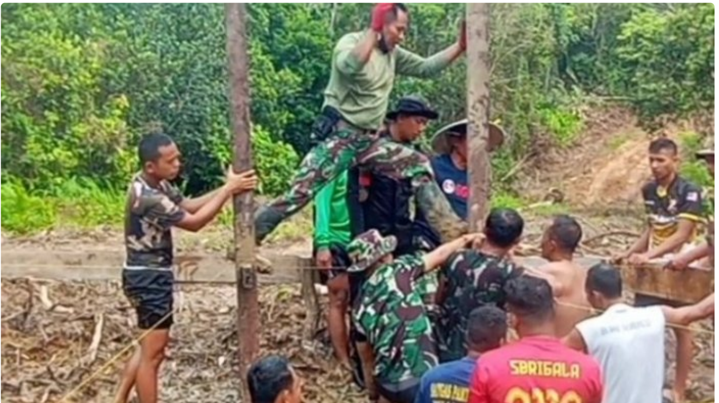
Satgas TMMD ke- 118 Wiltas Kodim 0910/Malinau Pasang Tiang Pancang Jembatan
