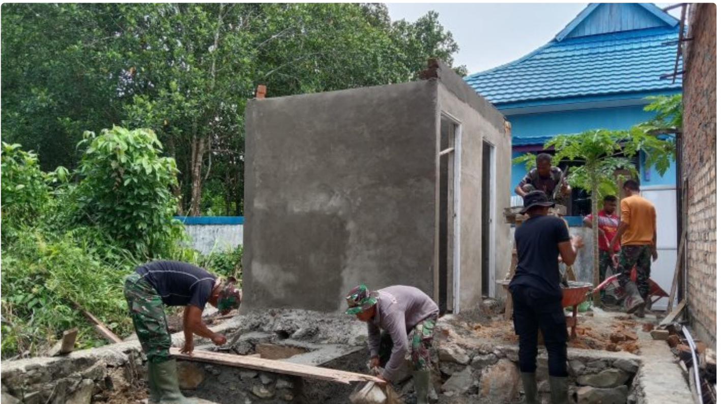
Satgas TMMD ke- 118 Wiltas Kodim 0910/Malinau Progres Pembuatan Septic tank MCK Gereja
