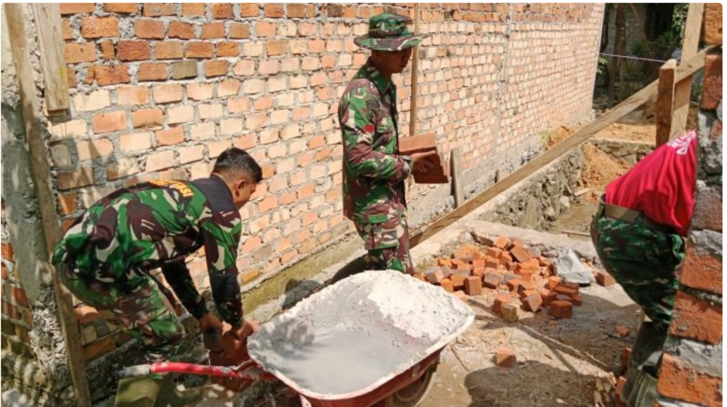
Satgas TMMD Ke- 118 Wiltas Kodim 0910/Malinau Terus Kebut Pembangunan MCK Gereja
